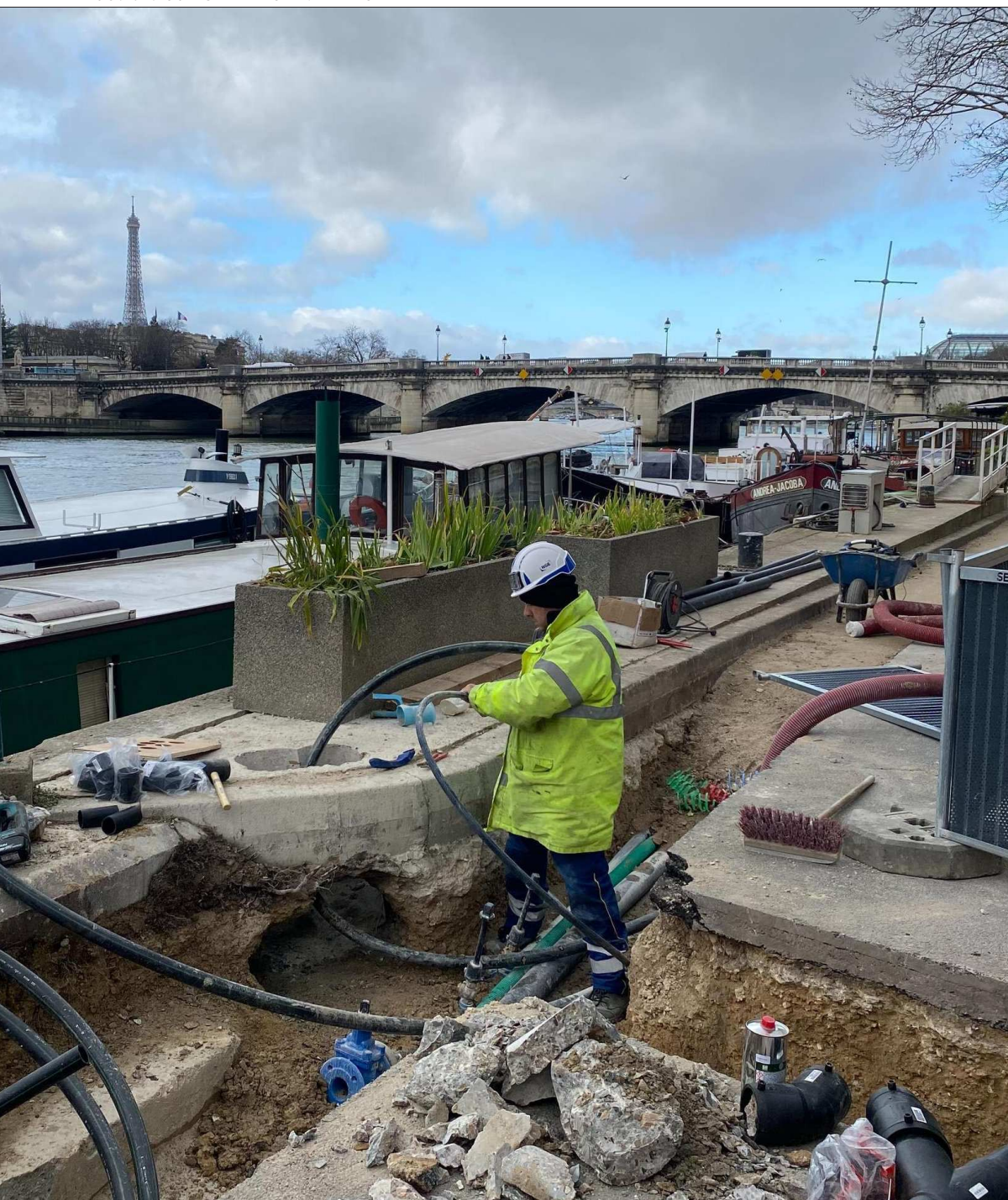
Port des Champs-Élysées (VIII e ). Les travaux ont démarré en début d'année. Ils font partie des chantiers à réaliser pour assainir le fleuve, avec ceux du traitement des eaux pluviales et des rejets des stations d'épuration, qui constituent l'essentiel de la pollution.
