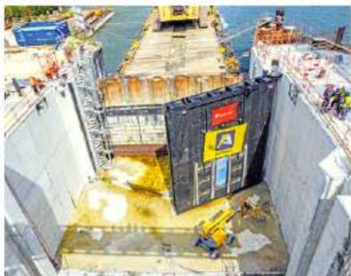
La livraison des deux vantaux étanches de la porte aval de l'écluse numéro un a eu lieu le 20 avril. Ils ont été posés l'un après l'autre. Hauts de 12 mètres pour une largeur de dix mètres, ils pèsent environ 80 tonnes chacun.
