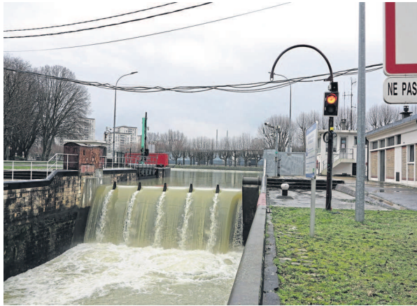
Joinville-le-Pont, hier après-midi. Avec 6,8 m de hauteur, 12 de large et un poids de 45 t, l'ouvrage est hors norme.
