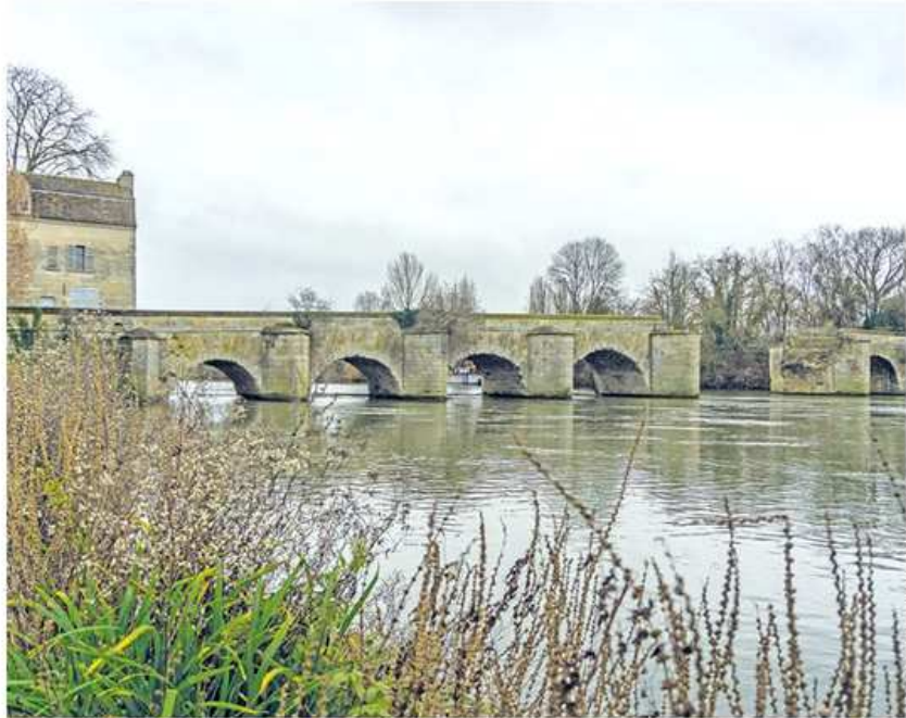
« Au final, ils vont conforter en eau par l'injection d'une résine polymère, qui est plus adaptée à la solution immergée », poursuit l'adjoint à l'urbanisme limayen Djamel Nedjar (DVG) qui espère une livraison de l'ouvrage « proche de 2024 ».
