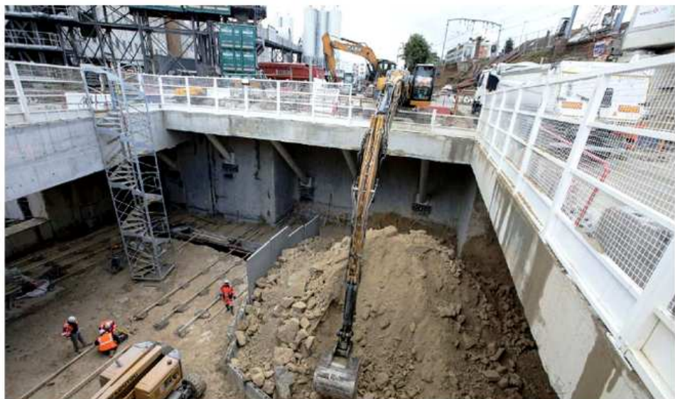
Arceuil-Cachan (Val-de-Marne), en juin. Cette gare du Grand Paris Express, située sur la ligne 15, est en travaux. D'ici à la fin de la construction du supermétro, près de 45 millions de tonnes de déblais auront été produites.
