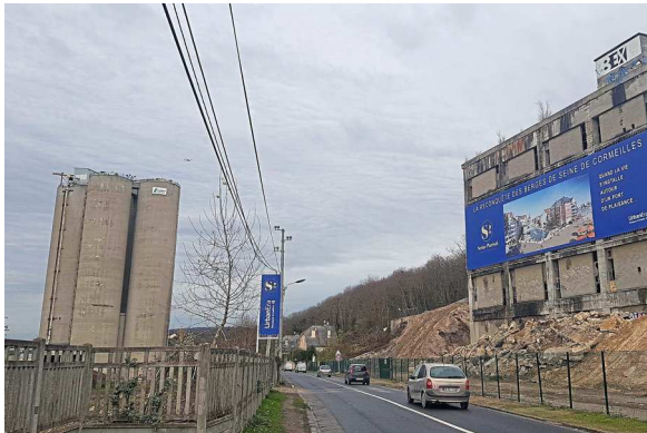
Cormelles-en-Parisis, hier. Les silos de l'ancienne friche industrielle seront détruits début février.
