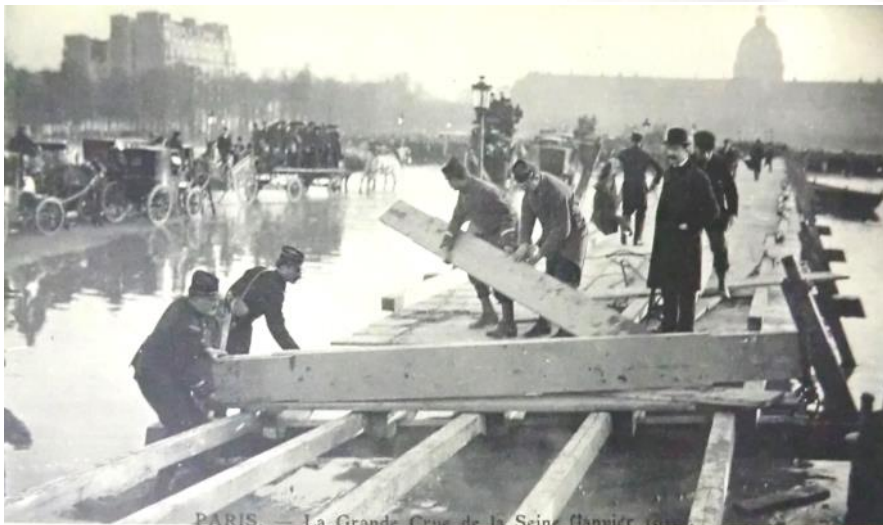
Les sapeurs du 2 e génie construisent un pont sur l'esplanade des Invalides, carte postale, janvier 1910. Archives de Paris, 8Fi 11.
