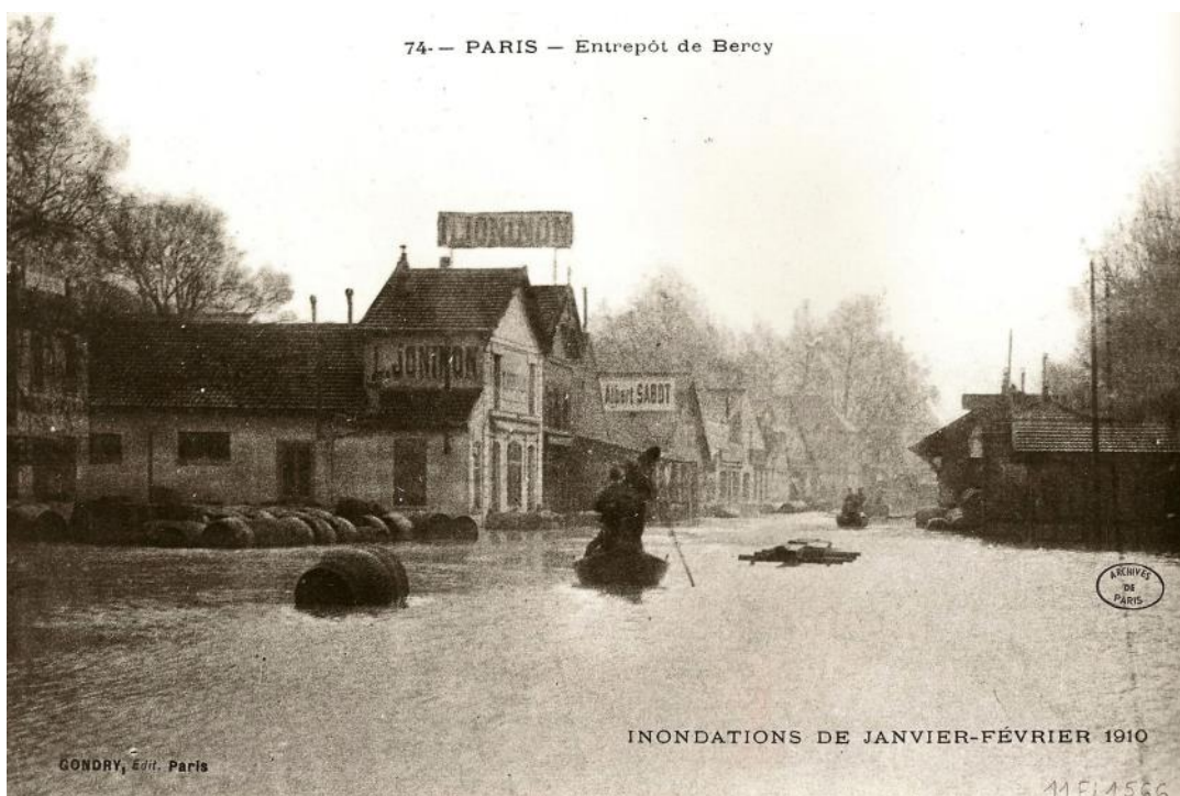
Entrepôts de Bercy inondés, janvier 1910. Archives de Paris, 11Fi 1566 et 11Fi 1562.
