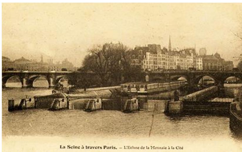
Le barrage-écluse de la Monnaie, carte postale, 1900. Archives de Paris, 8Fi 11.
