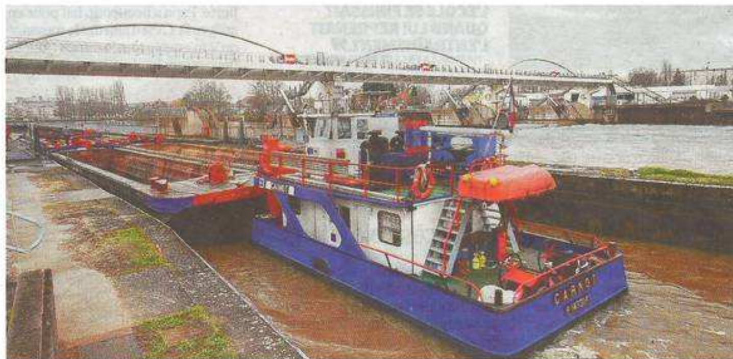
Barrage de Venette, canal Seine-Nord, début décembre. Avant de pouvoir accueillir le siège tant attendu, l'Agglomération de la région de Compiègne devra faire face à de sérieux concurrents, comme Noyon ou Cambrai (Nord).
