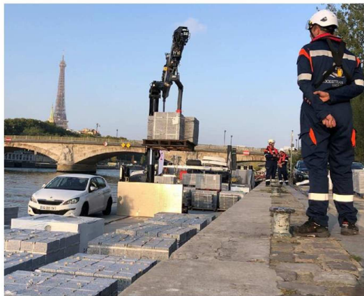
Paris (VIII e ). Les blocs de granit, sur une barge amarrée au port des Champs-Élysées, vont servir à la rénovation de la célèbre avenue.
